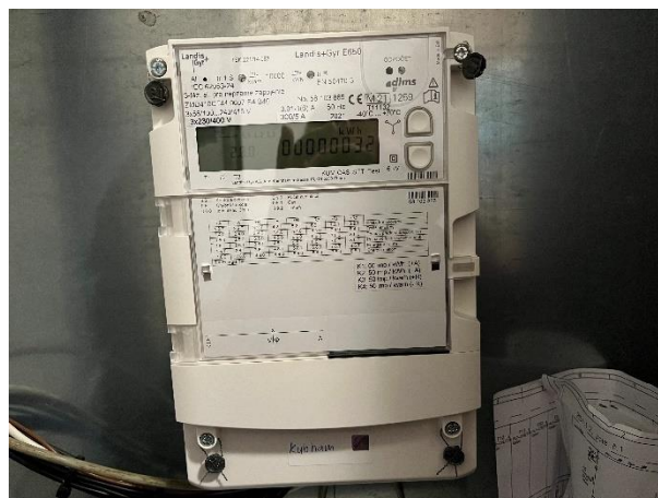
Obr. 3 Inteligentný elektromer Landis + Gyr E650 – meranie veľkodoberu na strane VN v DS
